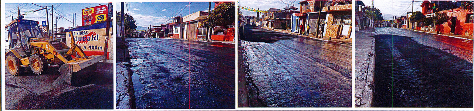
11. Calle Fernando Calderón entre las calles Miguel Hidalgo y Federico del Toro
