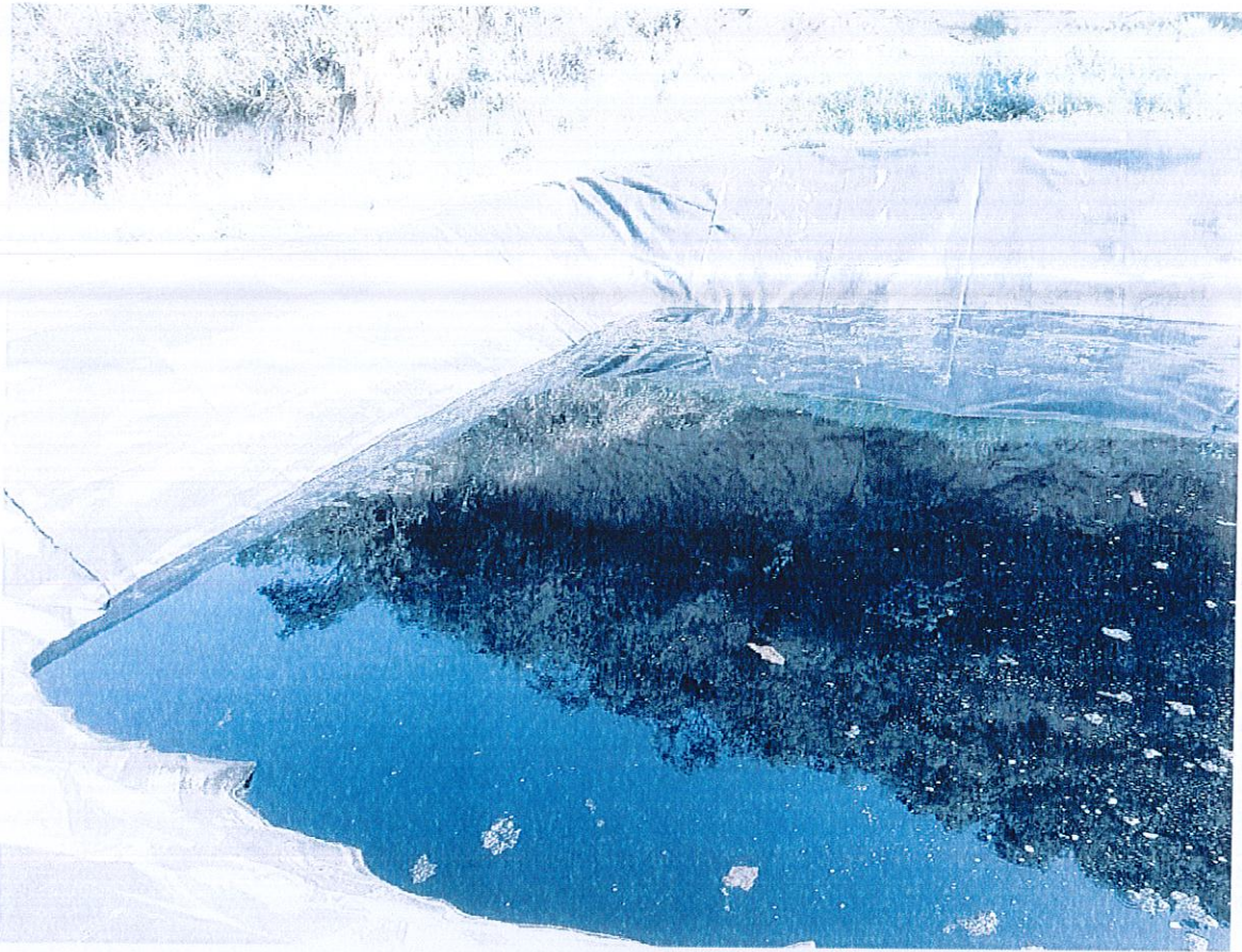
Fosa de Lixiviados en el Relleno Sanitario de Zapotlán El Grande.
