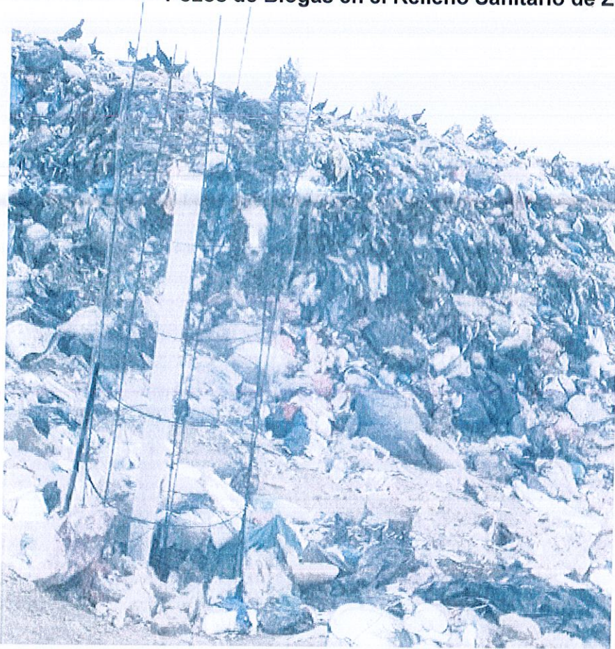
Pozos de Biogás en el Relleno Sanitario de Zapotlán El Grande.
