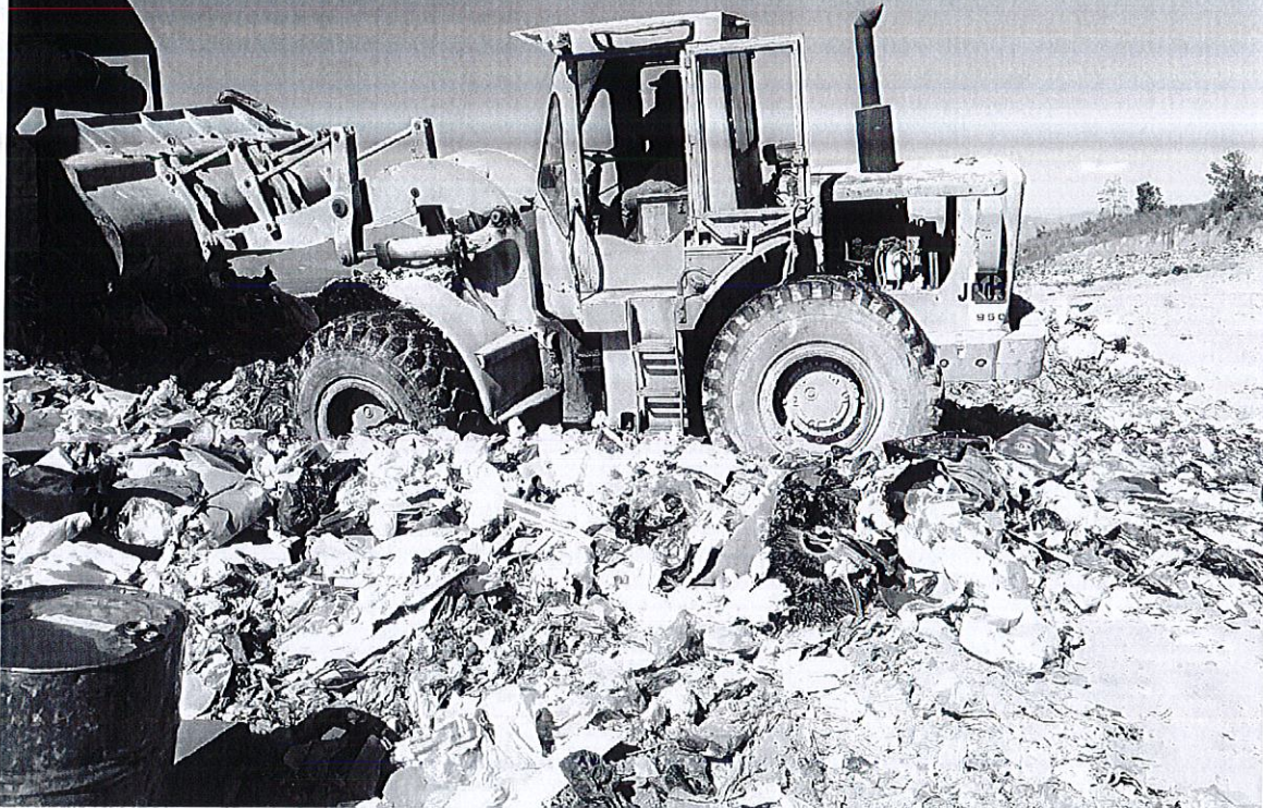
Bandeo con maquinaria pesada del material de cobertura de los Residuos Sólidos Urbanos
