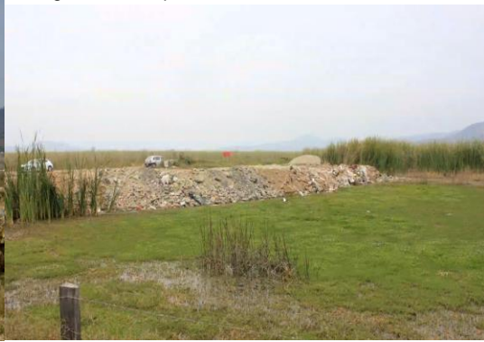
Figura 6. Terraplenes de escombros
