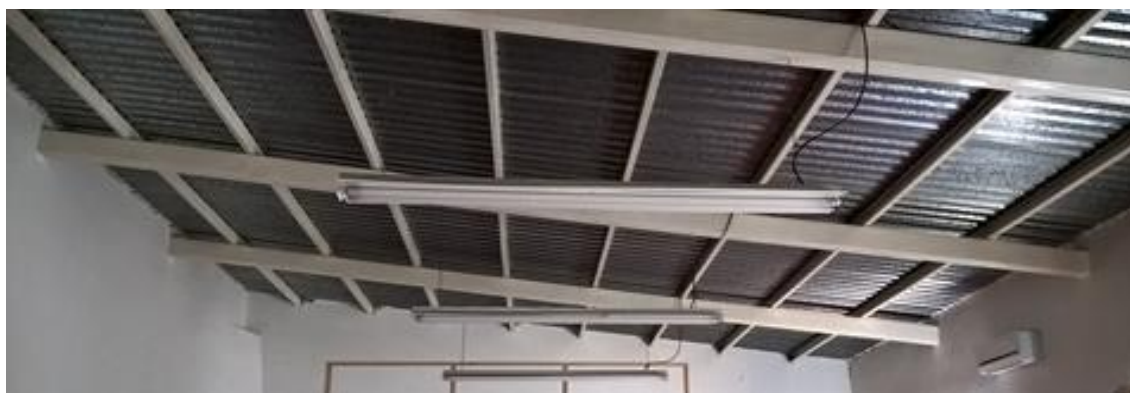
Vista de la reparación de los techos
